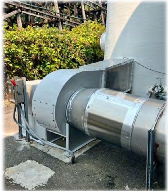
Odor control fan Installation.
